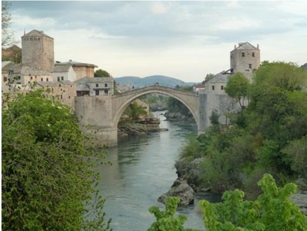
Blick auf die Brücke über die Neretva
